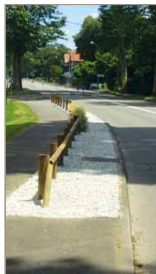
Voie verte RD817
